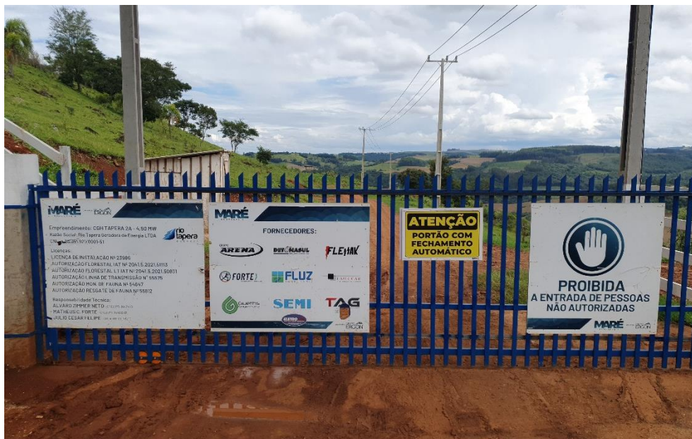
Figura 5 - Placas de identificação e informativas instaladas na CGH Tapera 2A.
